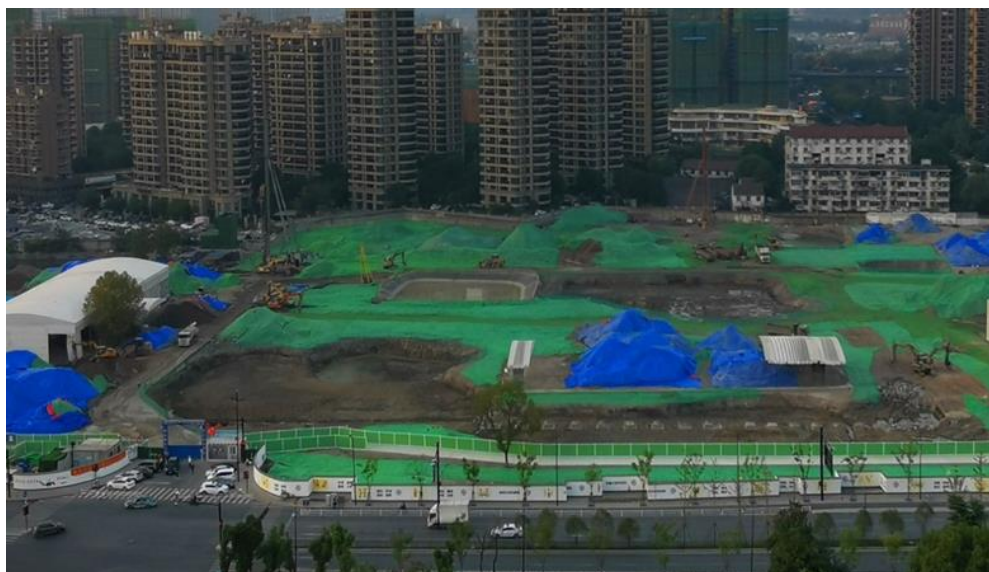
浙江新世纪金属材料现货市场退役地块修复工程（2021）
