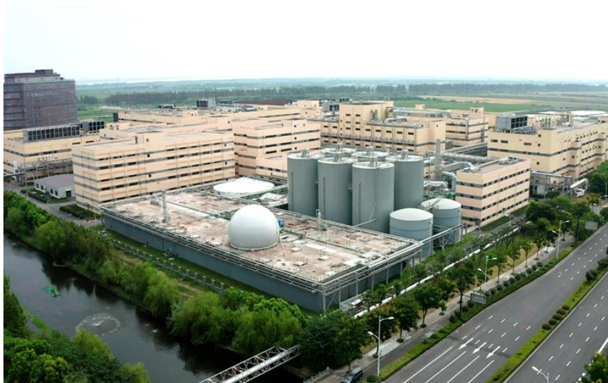
华东医药废水 EPC 总包项目（2021）
